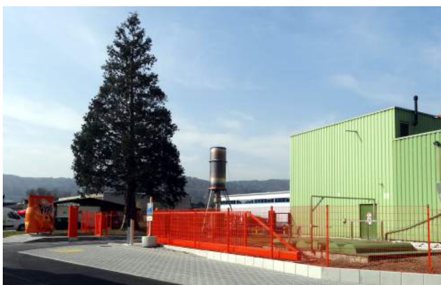
Der Doppelstab-Gitterzaun (H=1.80m) entspricht der Forderung nach funktionalem Design und hohem Sicherheitswert. Die Mattenkonstruktion garantiert Langlebigkeit und Servicefreundlichkeit.
