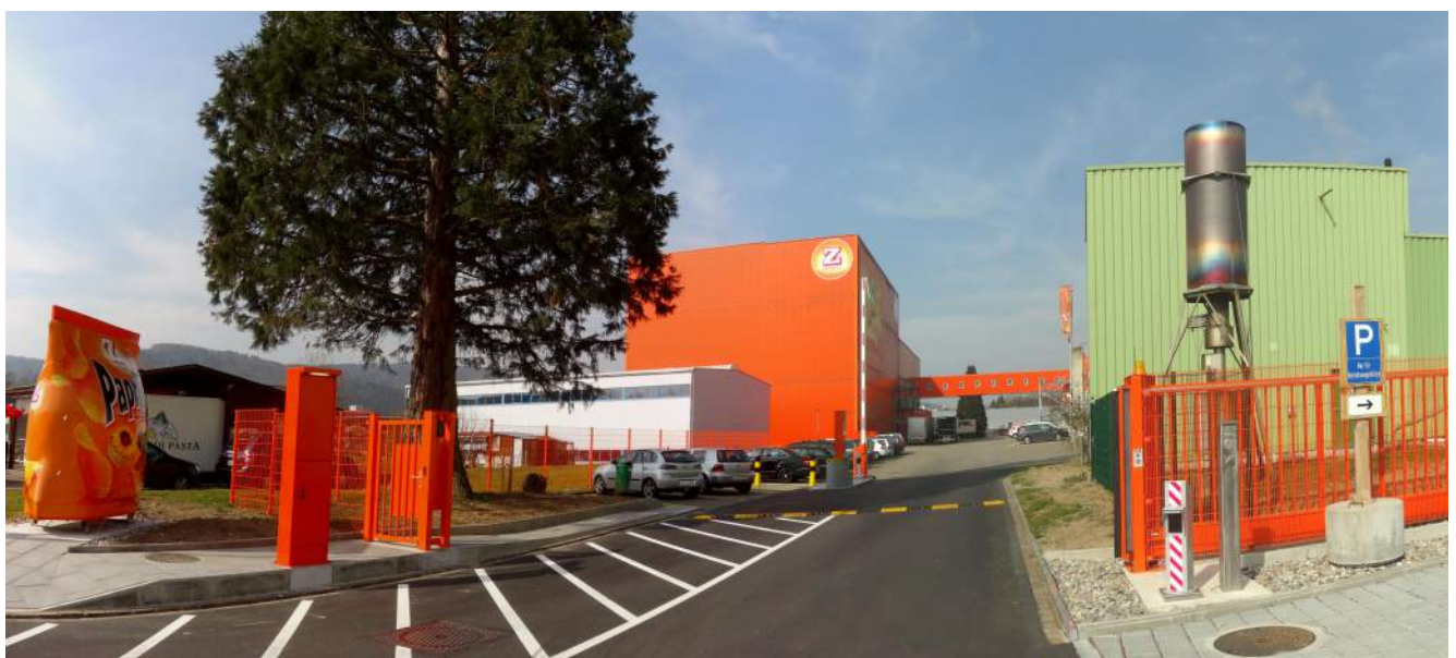
Sicherheitskonforme Zutrittskontrolle und Einzäunung
