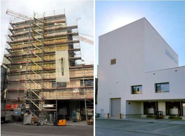
Der in die bestehend Gebäudestruktur integrierte Neubau «Turm».
