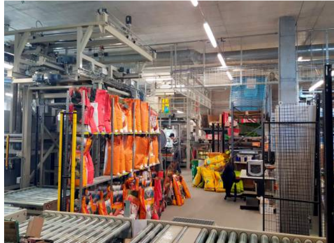
Neue, automatisierte Paletten-Transportanlage.
