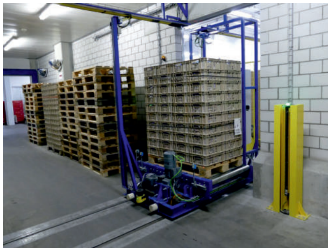
Das automatische Transportsystem mit dem integrierten Palettenaufzug ist die Basis für eine sichere und effiziente Produktion.
