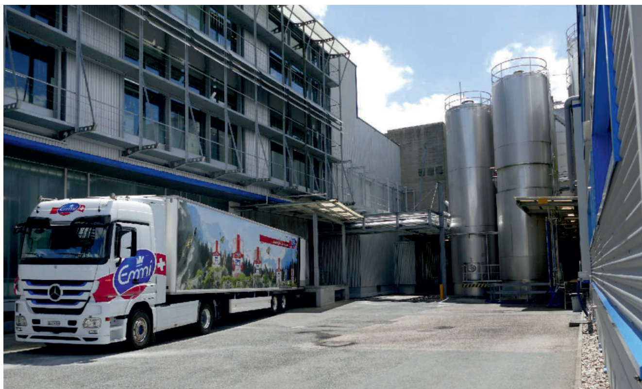
Für den Neubau im Innenhof mussten die Trassen mit den Versorgungsleitungen neu verlegt werden. Gleichzeitig wurde die Situation im Hinblick auf getrennte, kreuzungsfreie Personen- und Warenflüsse verbessert.
