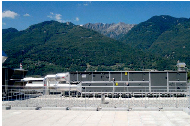
Dachterrasse mit Monoblock
